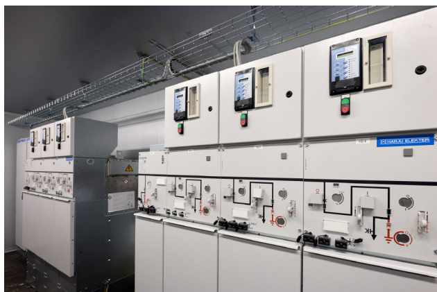
Mellanspänningsställverk, 22 kV.
